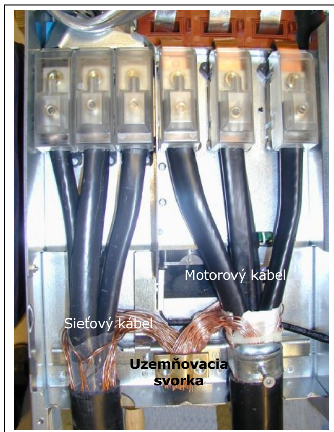
Obr. 6-16. Inštalácia káblov Vacon NX, FR8
